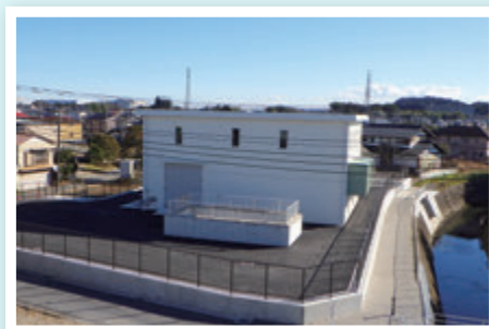
▲排水機場の整備
