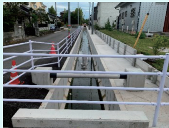
▲東茂原地区排水路
