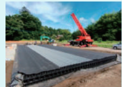
▲五郷福祉センター駐車場 地下貯留施設設置の様子
