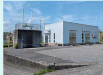
▲藤根排水機場
