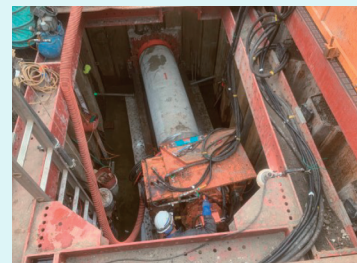
▲八千代地区の増補管整備工事
