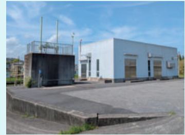
▲藤根排水機場
