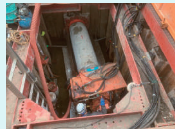
▲八千代地区の増補管整備工事
