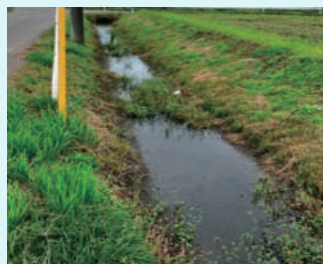
▲法目地先排水路
