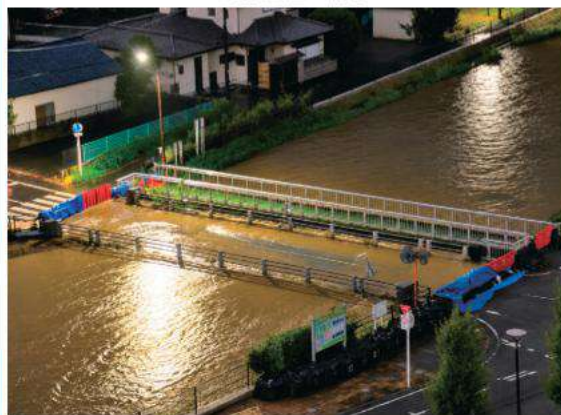
▲昌平橋に止水板(ボックスウォール)を設置
