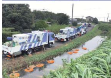
▲国から派遣されたポンプ車
