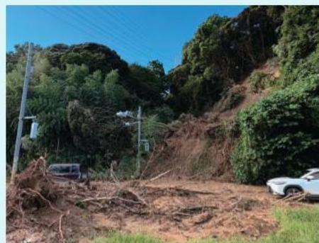
▲土砂崩れ（市内本納地先） 撮影日：9月22日
