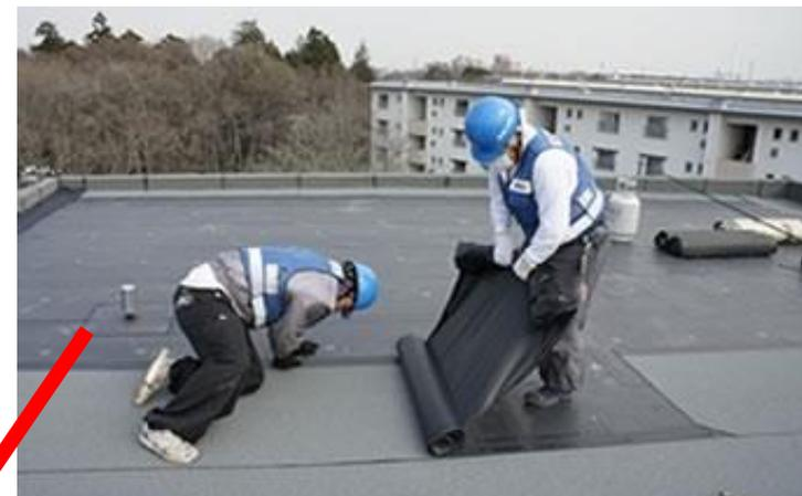
断熱材を新たに加え屋上防水改修を行い、断熱性の向上や耐久性向上を図ります。
