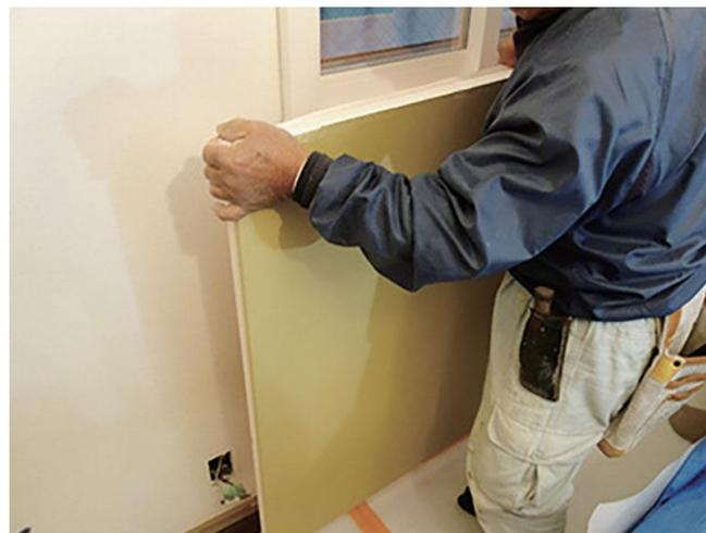
断熱材付きの石膏ボードを施工する。
