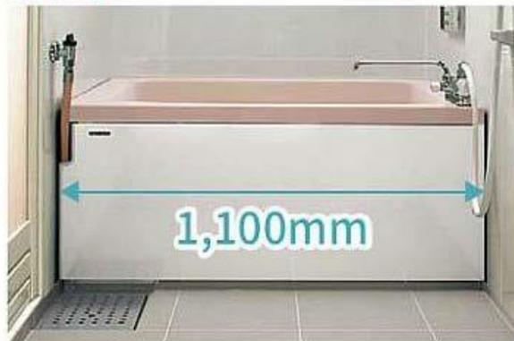
給湯器の設置により風呂釜の廃止を行うことにより、浴槽のサイズアップが図れる。また、手摺の設置などを行い高齢者対応も図る。
